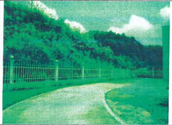
升压站西北侧通透式围墙
