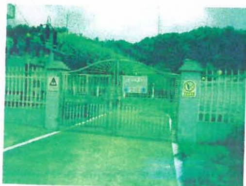
升压站工作区域门禁
